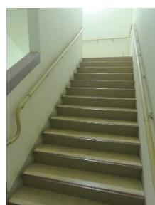
(両側に手すりを設置し転落、転倒災害の防止対策を実施)
