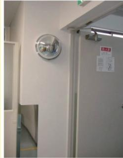
階段と廊下の交差部にカーブミラーを設置して、出会い頭の接触を防止している。
