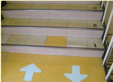
階段に通行区分を明示するとともに、事故が起りやすい最後の3段にカウントダウンの表示をして、注意喚起を行っている。
