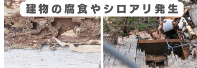
雨漏り発見の遅れによる 建物の腐食やシロアリ発生
