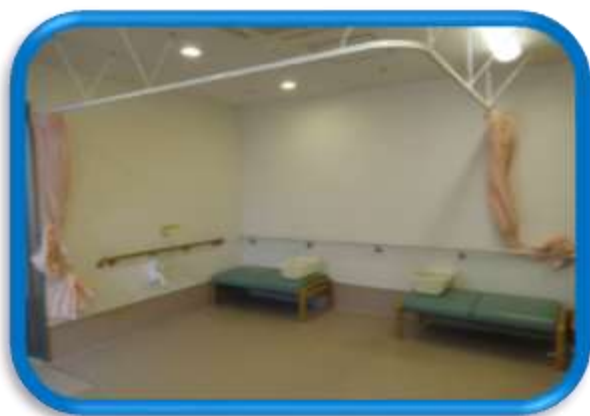
<以前の脱衣スペース>
